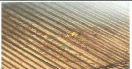
Foto 6: sustitución de lamina normal por lamina troquelada calibre 26 en la direccion, bodega y tres aulas
