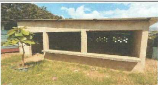
Foto 4: colocación de balcon, puerta en la cocina
