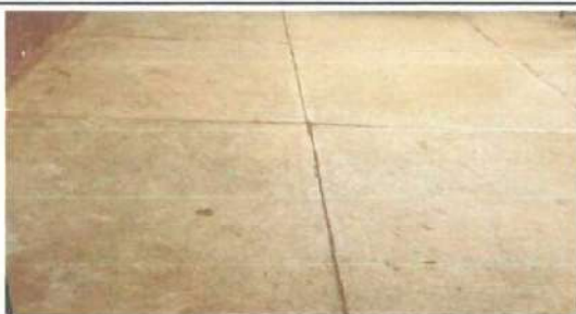
Foto 3: sustitución de piso rústico por piso cerámico en dos aulas
