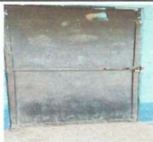
Foto 5: mantenimiento de 4 puertas lijadas y pintadas de 3 aulas + dirección, tres puertas del baño
