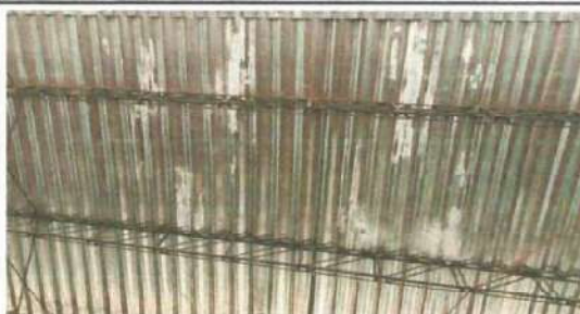
Foto 2: Sustitución de estructura de hierro por costanera de metal 2x4 y tijeras con tubo 4x4 chapa 16 en tres aulas y dirección
